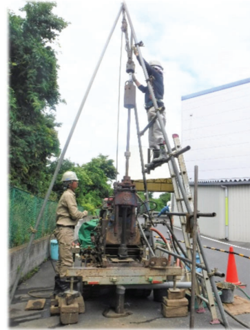
ボーリング実施状況
